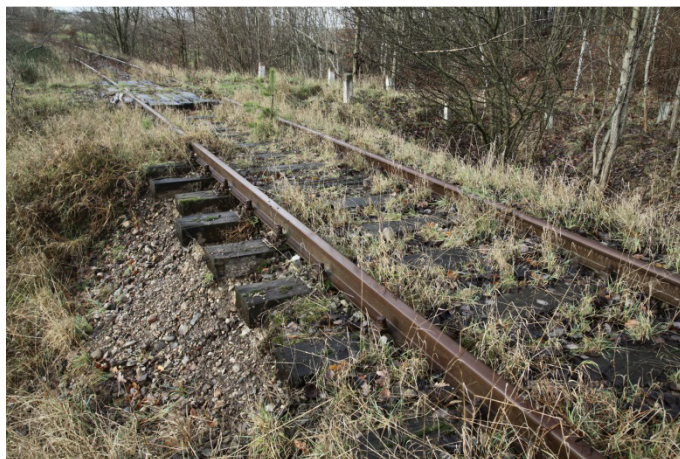
Rys. 11 – Erozja tęcznia wskutek braku odwodnienia
