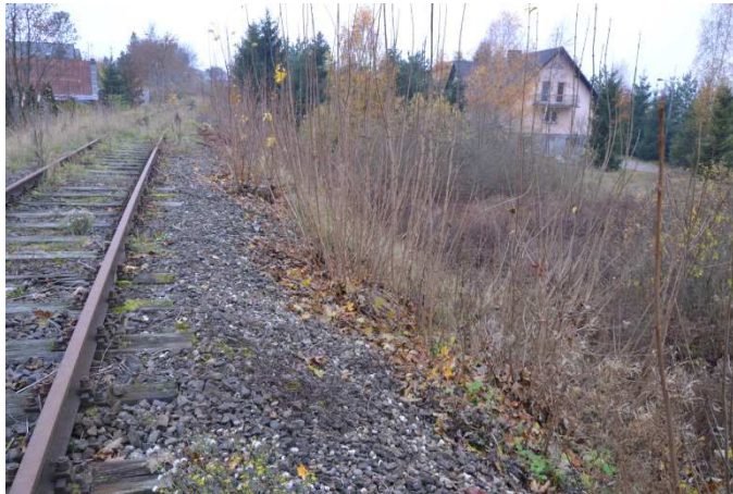
Rys. 16 - Utrata stateczności prawej skarpy – strona od Jeziora Łapalickiego
